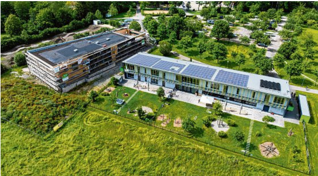
Hier ist von oben zu sehen, wie die beiden Gebäude angeordnet sind. Auf dem Bild vom Juni 2024 fehlt noch der Verbindungsgang zwischen den beiden Gebäuden.
