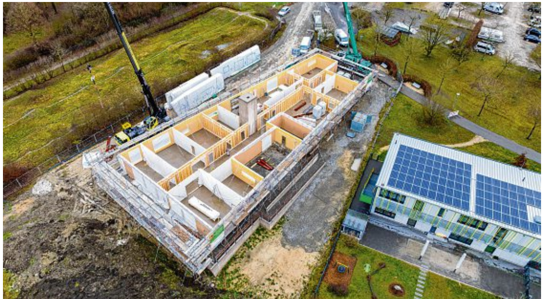
Die Decke fehlt noch. Bei der Anlieferung der Wände im Dezember 2023 ist von oben deutlich die Anordnung der Räume zu sehen. FOTOS: HANS-JÜRGEN GÖTZ
