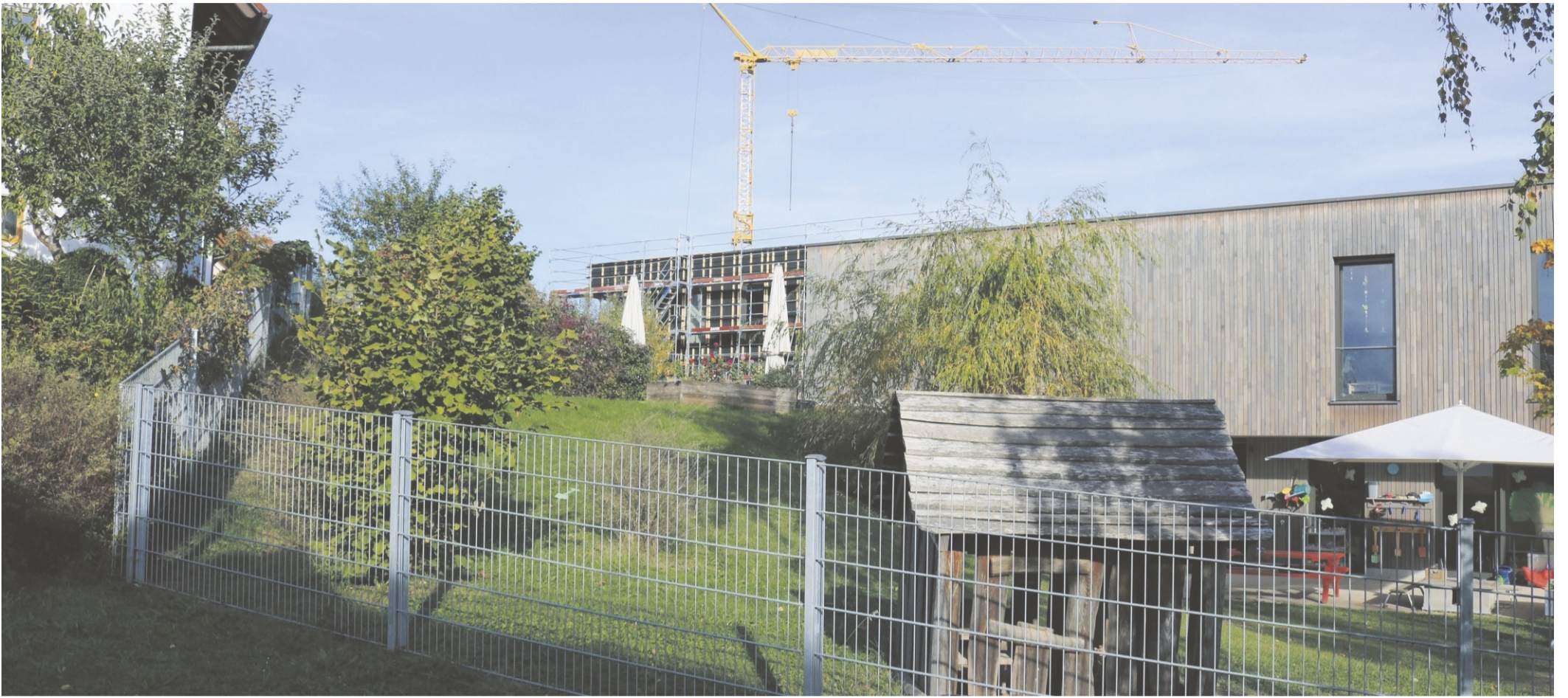
Im 2015 errichteten Kinderhaus in der Schulstraße wird es eng. Um mehr Platz zu schaffen wurde 2020 der Erweiterungsbau (links hinten) durch den Gemeinderat beschlossen. Man hofft nun, im ersten Halbjahr des nächsten Jahres die neuen Räumlichkeiten beziehen zu können. Fotos: Birgit Uhl
