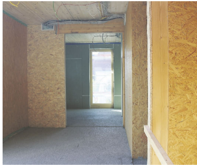
Noch ist nicht wirklich zu erahnen, wie es im Neubau einmal aussehen wird. Hier wurde gerade der Estrich im Obergeschoss gegossen.
