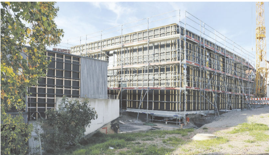
Das bisherige Kinderhaus (links) ist über einen Gang mit dem Neubau verbunden. Diese zentrale Verbindung wird zukünftig den neuen Haupteingang bilden.
