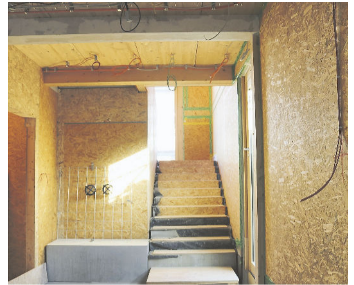
Linker Hand befindet sich der Aufzugsschacht, der neben der Treppe in das neue Obergeschoss führt. Fotos: Birgit Uhl
