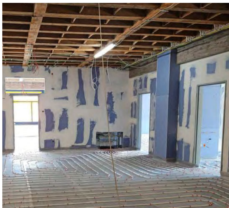
Das Dach des Dusch- und Umkleidetrakts der Sporthalle, das gleichzeitig als Pausenhof dient, musste abgedichtet werden (oben). In den Räumen der Schule wird Fußbodenheizung installiert (links).
