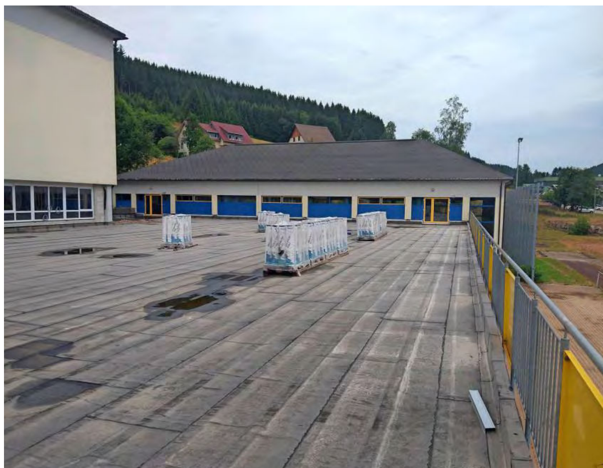
Das Dach des Dusch- und Umkleidetrakts der Sporthalle, das gleichzeitig als Pausenhof dient, musste abgedichtet werden (oben). In den Räumen der Schule wird Fußbodenheizung installiert (links).
