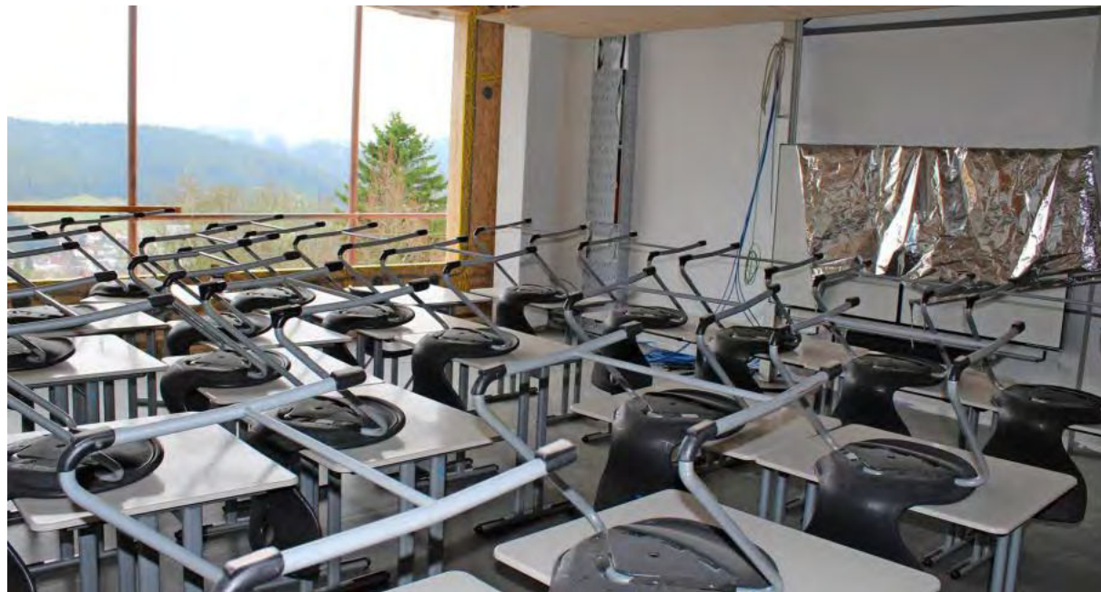
Für die Sanierung wurde das Schulgebäude vollständig entkernt. FOTO: STADTVERWALTUNG FURTWANGEN
