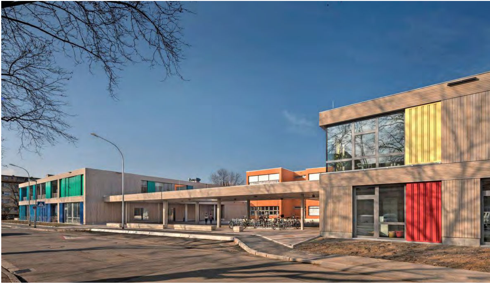
Die beiden Neubauten für Schulkindergarten, Kindergarten und Ganztagsbetreuung wurden in Massivholzbauweise errichtet. FOTOS: STADT FREIBURG
