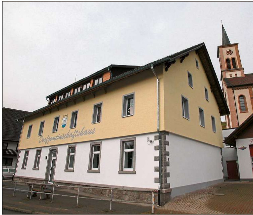
Rund 120 Jahre alt ist das ehemalige Rohrbacher Schul- und Rathaus. Nach jahrelanger Vorbereitung und vielen Investitionen ist daraus ein Schmuckstück mit moderner Innenausstattung geworden. Foto: Liebau
