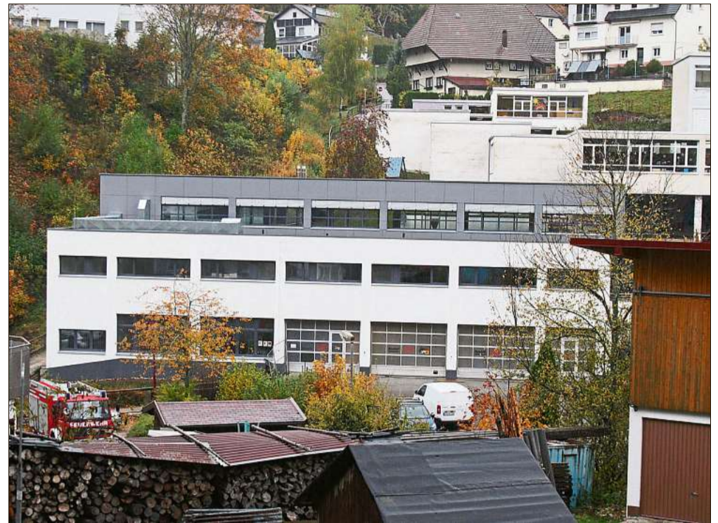
36 Unternehmen waren an der Sanierung der Gütenbacher Mehrzweckhalle beteiligt. Foto: Liebau
