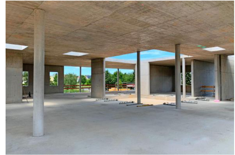
Offene Lernzonen in dem Neubau sollen eine flexible Nutzung ermöglichen.
