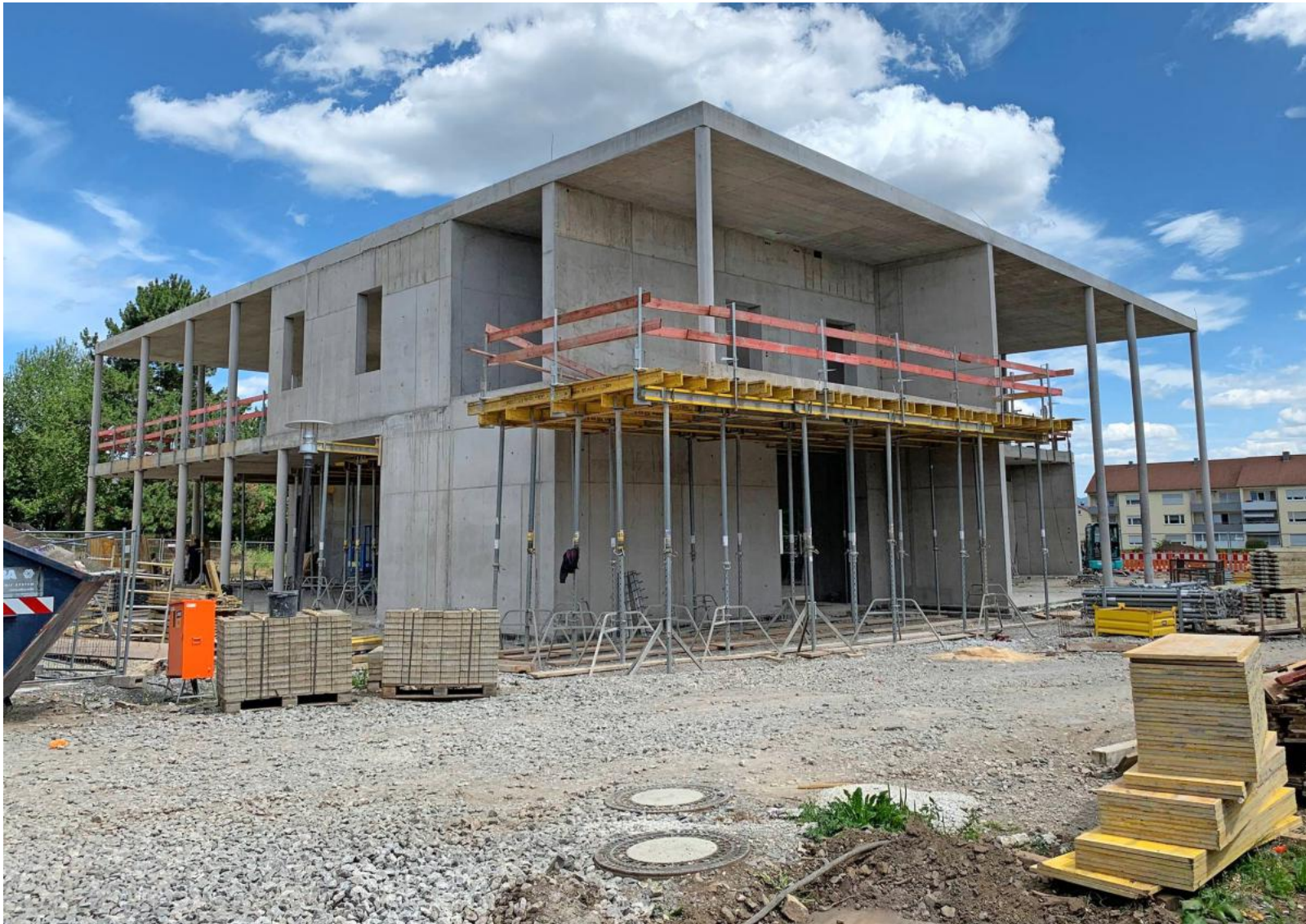
Betonbau mit offenen Seiten: Das zweigeschossige Bauwerk soll großzügig verglast werden. Es beherbergt künftig Mensa und Medienzentrum. FOTOS: KILIAN+PARTNER
