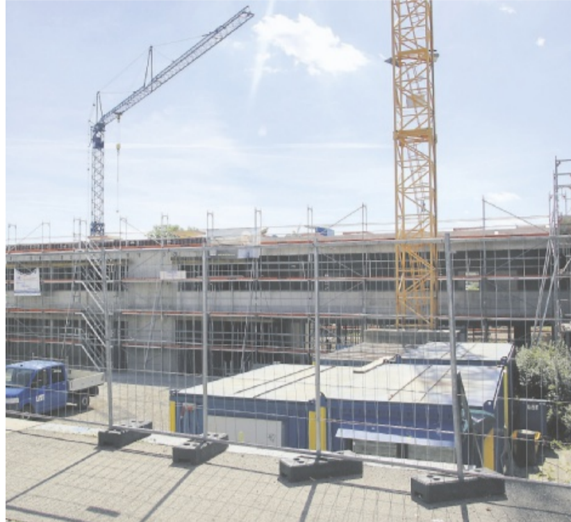
11,4 Millionen Euro lässt sich die Gemeinde den Neubau des Deißlinger Schulzentrums kosten. Die Arbeiten laufen trotz der Einschränkungen durch die Coronavirus-Pandemie nach Plan, genau ein Jahr nach dem Baubeginn konnte Ende Juli das Richtfest gefeiert werden. Fotos: Moni Marcel
