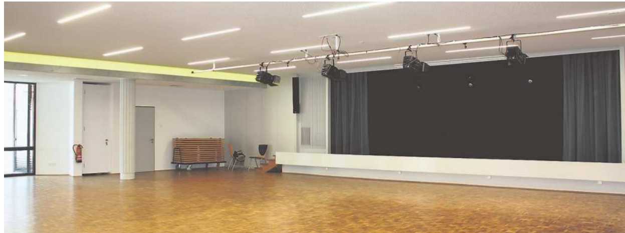
Mit einer Akustikdecke sowie neuer Beleuchtung und Lichttechnik wurde der Pfarrsaal deutlich aufgewertet.
