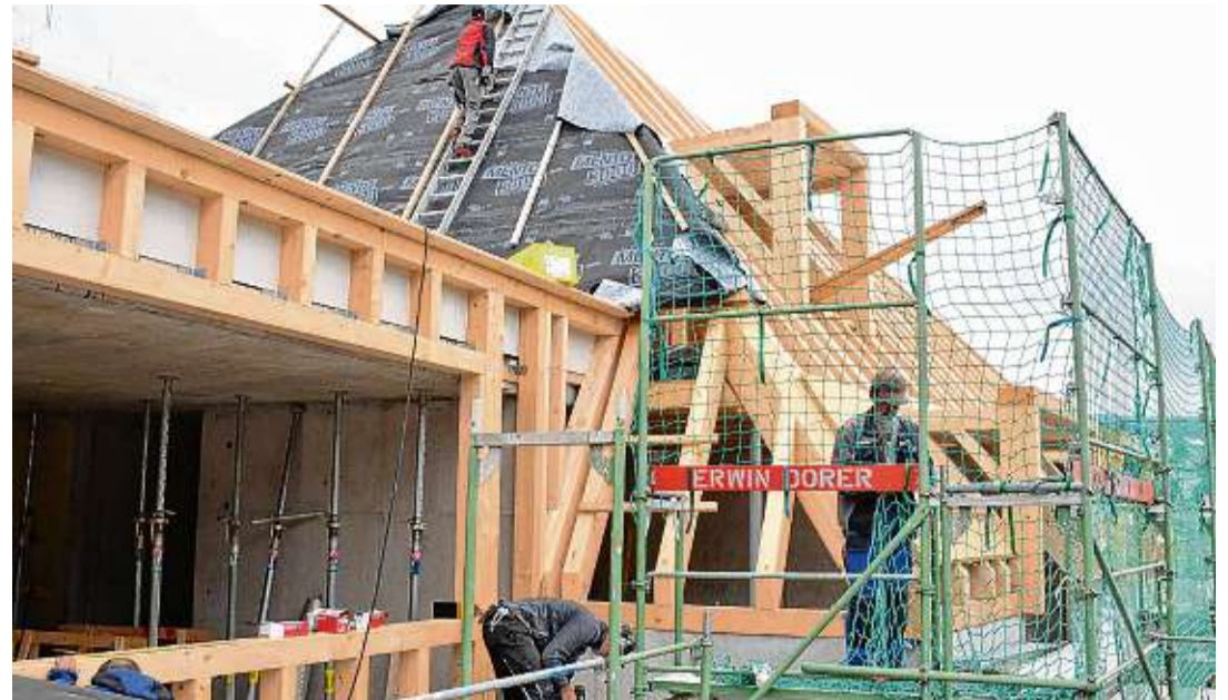
Auf dem Dach des Solitärgebäudes laufen die Vorbereitungen für das Richtfest am 30. August. Dann wird von dort der Richtbaum weithin grüßen.
