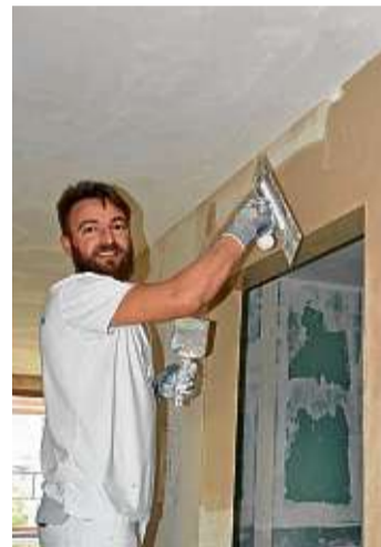
Der Innenausbau läuft derzeit auf vollen Touren.
