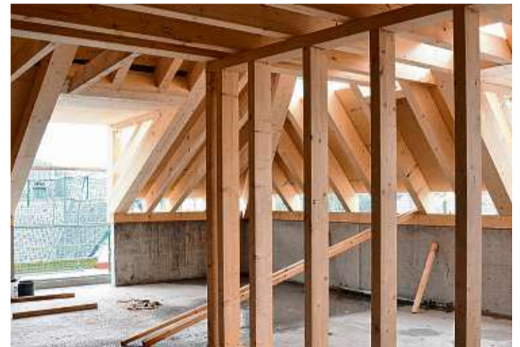
In der Bauweise sehen sich Architekt und Bauherr der Nachhaltigkeit verpflichtet. So weit es möglich ist, kommt Holz zum Einsatz. BILDER: RITA BOLKART
